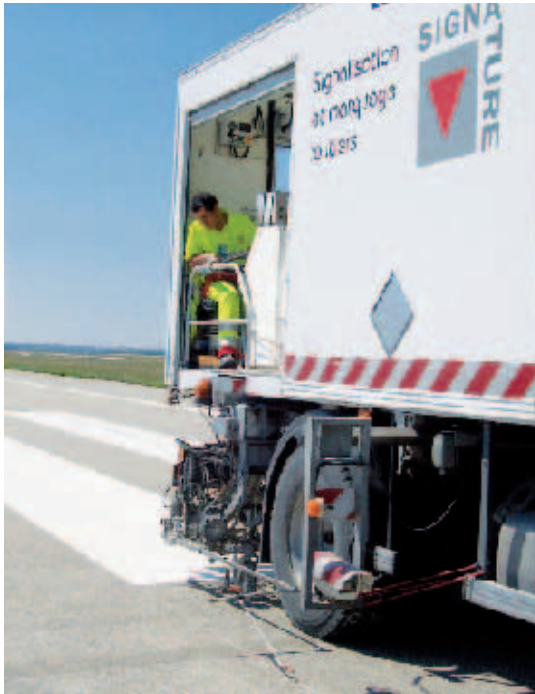
Prestation de marquage routier
