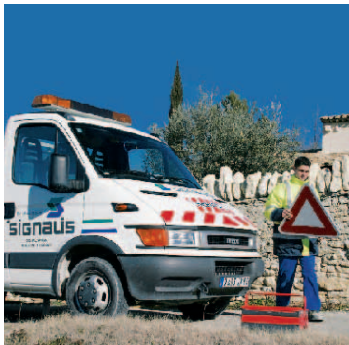
Mise en place de panneaux de police par une équipe de Signalis
